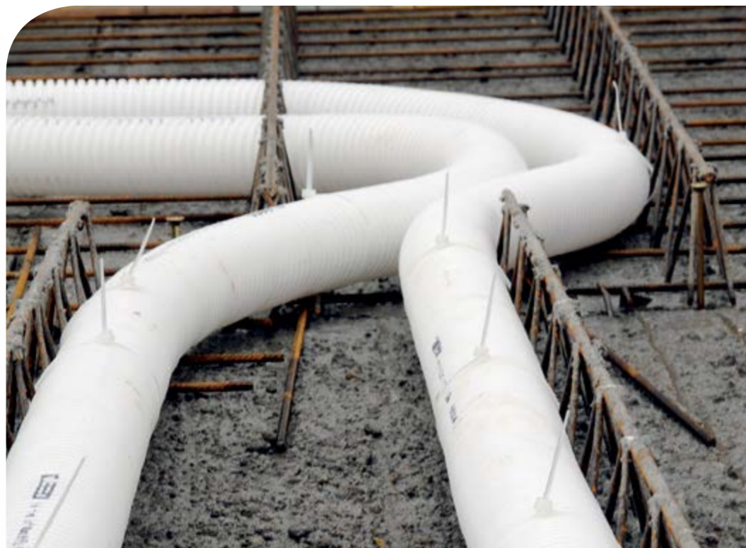
Rury Zehnder ComfoTube posadowione w wylewce betonowej
