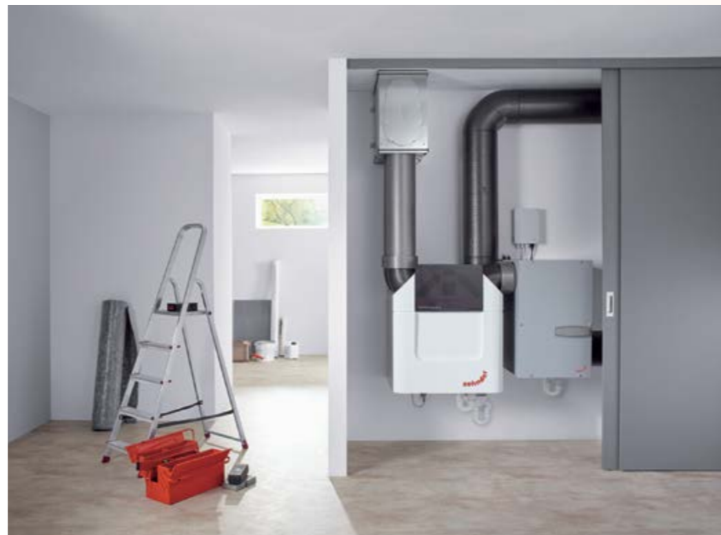
Montaż systemowego wymiennika glikolowego dla podniesienia sprawności układu
